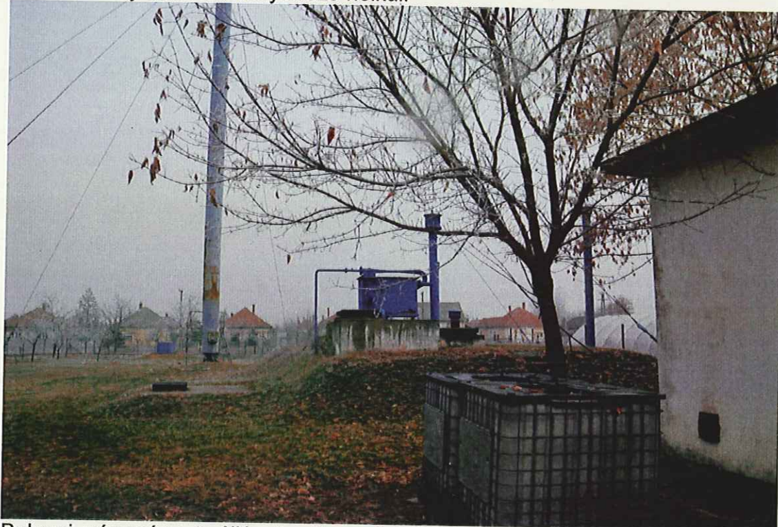
Bokrosi városrész önálló vízműve gépházzal 2*50 m 3 -s mélytározóval 50 m 3 -s hidroglobusszal, használaton kívüli LVS gáztalanítóval. (Programba részlegesen bevont.
